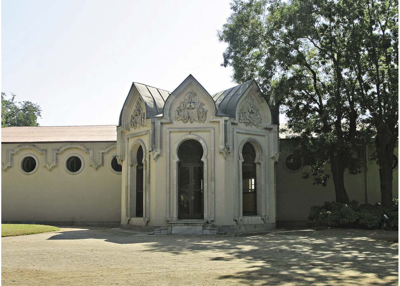
26 Ahır Köşkü dış cephe görünümü
